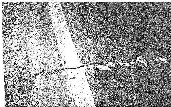
شکل (۶): گسلش سطحی در جاده بم - پروات جابجایی چپ گرد در حدود ۳ سانتیمتر است
