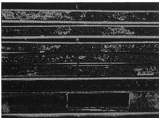
شکل (۹) گستردگی خوردگی بر سطح آرماتورهای فولادی پس از تخریب نمونه های بتنی حاوی سیمان نوع I با عرض ترک متفاوت.
